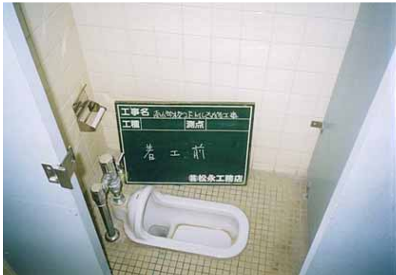
和洋リモデル工法による現場実例1
